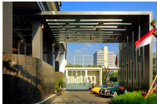
Gambar 2. The Akmani Hotel Jakarta: Penaikan Elevasi Lobby sebanyak 3 meter dari permukaan tanah (Sumber: archdaily.com )
