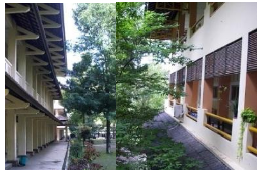
Gambar 13. Gedung kampus hijau
