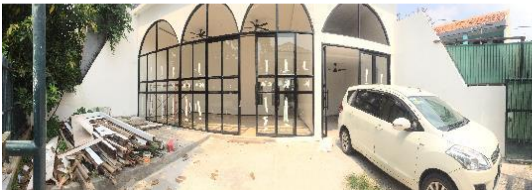
Gambar 1. Kondisi Eksisting BM Office
