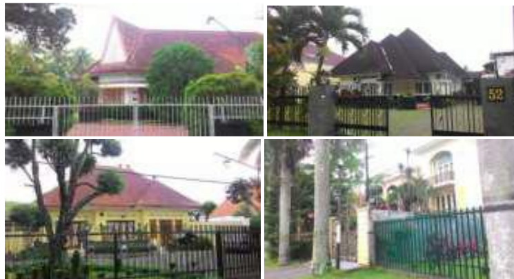
Gambar 6. Beberapa bangunan hunian di Jalan Ijen. Sebagian bangunan karya Thomas Karsten masih mempertahankan bentuk arsitektur aslinya, dan sebagian lagi sudah berubah menjadi bangunan baru (kanan bawah).
