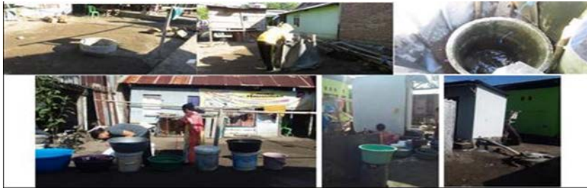
Gambar 5. Sumber air bersih untuk MCK dari sumur. MCK umum Jarak antara lubang septiktan dengan sumur adalah 4 m
