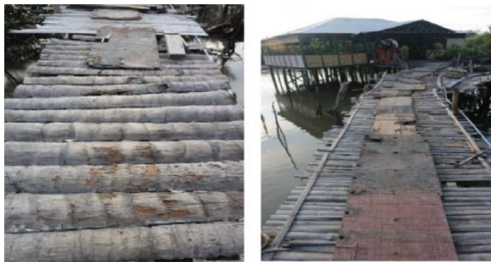
Gambar 5. Jembatan yang berada di Kawasan Ekowisata
