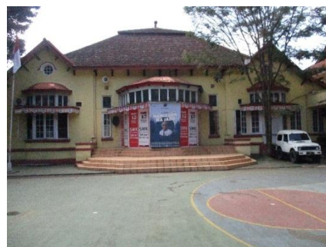
Gambar 3. Bangunan Heritage Golongan A
