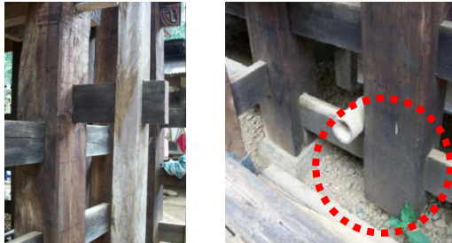
Gambar 3 dan 4. Penguatan antara kolom dan balok sehingga tidak saling bergoyang.
