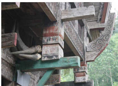
Gambar 5. Sambungan antar balok-balok.
