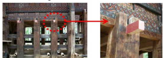
Gambar 2. Ikatan kolom dan balok.
