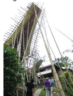
Gambar 1. Atap bangunan sebagai pembeban.
