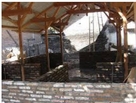
Gambar 6. konstruksi dinding dari daur ulang
