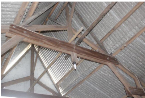
Gambar 8. Detil Rangka Atap Bangunan
