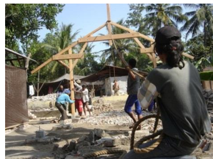
Gambar 5. Proses konstruksi pemasangan rangka bangunan rumah
