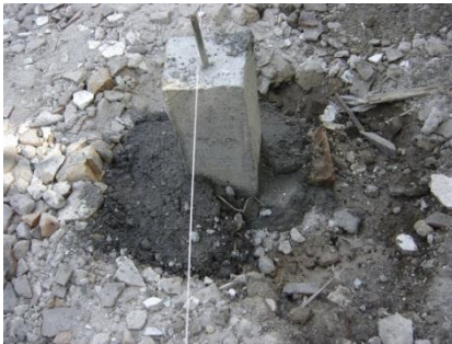
Gambar 7. Konstruksi umpak sebagai pondasi Bangunan
