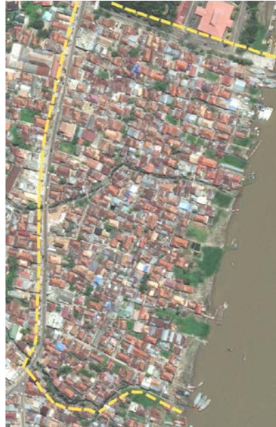
Gambar 4. Foto udara tepian sungai 35 Ilir
