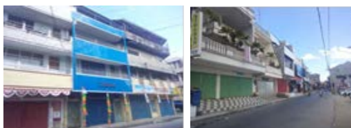
Gambar 2. Arsitektur Bangunan Toko di Kawasan Kota Lama (koridor Jl. Siliwangi ) (sumber: dokumentasi penulis,2018)
