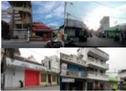
Gambar 17. Tempat ibadah (Klenteng), kawasan perdagangan (toko sekaligus hunian) di Kampung Cina (Dokumentasi peneliti tahun 2017)
