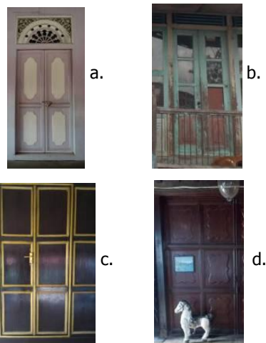
Gambar 11. a. Pintu pada rumah gudang di kampung Almunawar, b. Pintu pada rumah gudang di lorong firma, c. Pintu pada rumah limas 1, d. Pintu pada rumah limas 2
