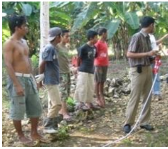
Gambar 3. Pembuatan Jalan Lingkungan warga Desa Pacing
