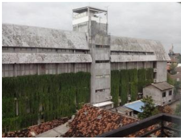
Gambar 16. Tanaman terurai kebawah sebagai tirai pencegahan terik matahari dari sisi Barat, dapat menurunkan suhu panas dalam ruang
