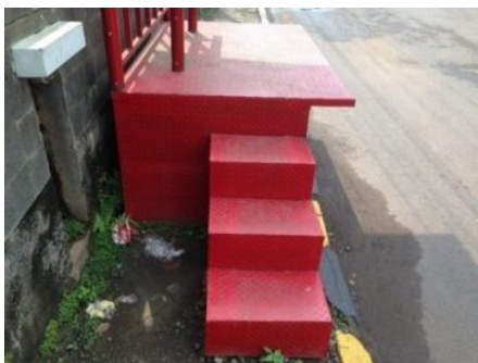
Gambar 9. Akses Tangga Shelter BRT Koridor VI GSG Unnes, Sumber: Hasil Survei, (2017)
