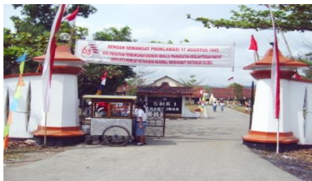
Gambar 16. SMK 1 Banyumas Nama Bangunan : SMK 1 Banyumas Kepemilikan : Dinas Pendidikan Nasional Fungsi Awal : Kantor Residen Fungsi Sekarang : Sekolah
