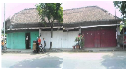
Gambar 5. Toko Nama Bangunan : Toko Kepemilikan : Individu Fungsi Awal : Tempat Tinggal Fungsi Sekarang : Toko dan Tempat Tinggal
