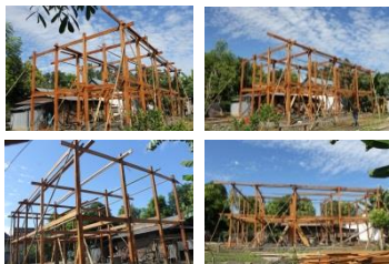
Gambar 6. Proses mendirikan rumah panggung kayu di Paowe kecamatan Lalabata Sumber : Hasil survey lapangan, 2016
