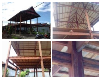
Gambar 9. Rumah panggung kayu dalam tahapan pekerjaan finishing Sumber : Hasil survey lapangan, 2016
