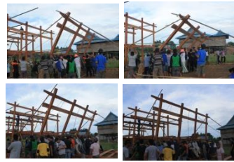
Gambar 3. Proses mendirikan rumah panggung kayu di Panincong kecamatan Mario Riawa Sumber : Hasil survey lapangan, 2016
