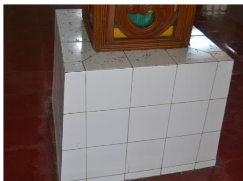
Gambar 5. Penambahan Pondasi Umpak Tiang Masjid Kesultanan Ternate setelah renovasi (peneliti, 2016).
