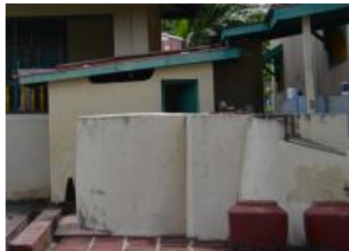
Gambar 7. Tempat wudhu yang baru ditambahkan pada Masjid Kesultanan Ternate setelah renovasi (peneliti, 2016).
