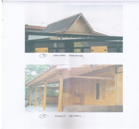
Gambar 12. Tampak samping dan sudut teras depan rumah pak Harwoto, Prenggan.
