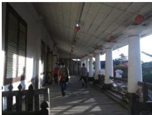
Gambar 6. Struktur Kolom Beton dan material kayu pada lantai dan plafon (Sumber : Koleksi Pribadi)
