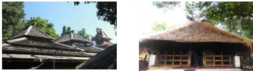
bangunan menggunakan atap sirap; bangunan menggunakan atap welit
