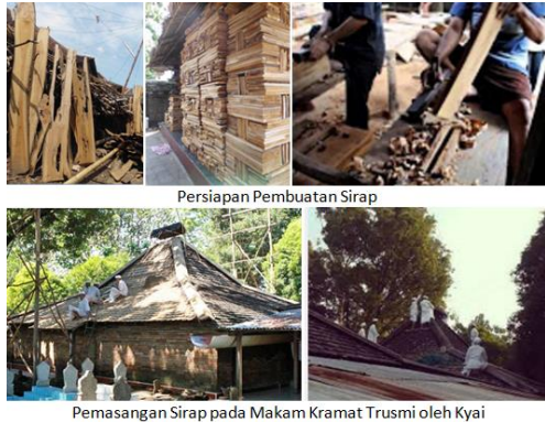
Gambar 8. Proses Penggantian Atap Sirap (Sumber: Dokumentasi Pribadi, 2012-2014)
