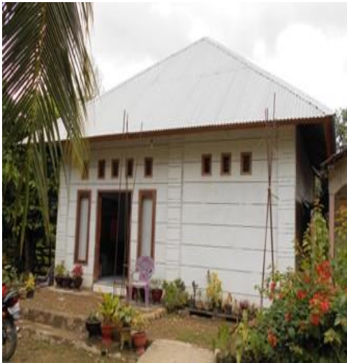
Gambar 1. Rumah Bapak Mashari yang didirikan dengan menggunakan sistem arisan bahan bangunan dan uang (Sumber: hasil dokumentasi, 2016).
