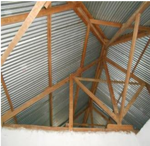
Gambar 2. Rumah Bapak Mashari yang menggunakan konstruksi kuda-kuda kayu dan jenis atap seng (Sumber: hasil dokumentasi, 2016).
