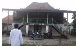
Gambar 3. Rumah Panggung Permukiman Pasang Surut 7 Ulu Tepi Sungai Musi Palembang. (sumber: Observasi Lapangan, 2016)
