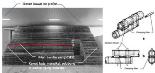
Gambar 12. Ikatan kawat sebagai penguat konstruksi instalasi.
