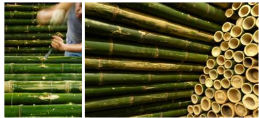
Gambar 10. Kiri: pekerja membuat coakan pada bambu; kanan: bambu disusun secara rigid sebagai penopang instalasi.
