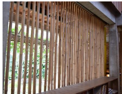
Gambar 7. Penggunaan bambu sebagai jalusi yang memungkinkan pandangan keluar rumah
