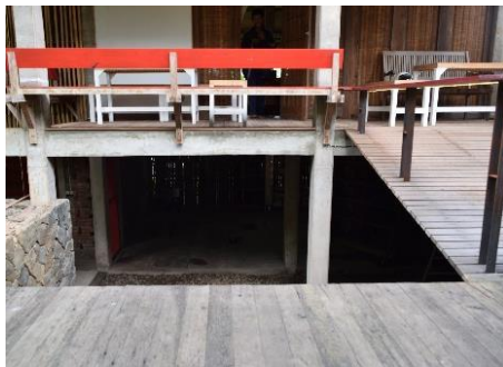
Gambar 8. Kayu bekas yang digunakan sebagai lantai
