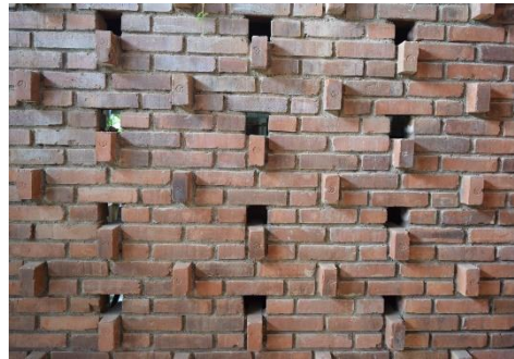
Gambar 6. Dinding dengan material bata yang diekspos, serta lubang yang memungkinkan udara masuk ke dalam bangunan
