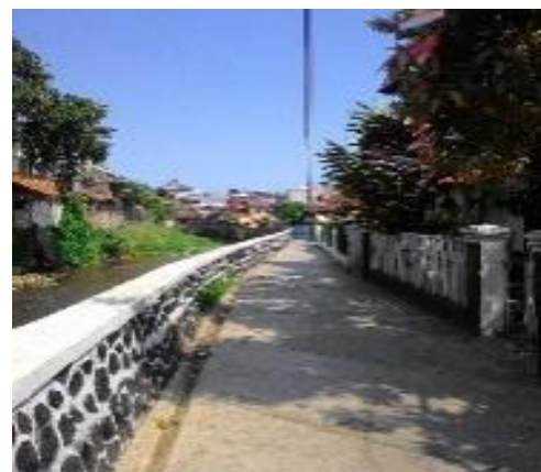
Gambar 8 (atas-kiri). Kondisi vegetasi dan bangunan di sisi selatan sungai Cikapundung
