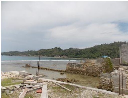
Gambar 3. Alih fungsi guna lahan kawasan tepian laut/pesisir sebagai tapak bangunan hotel dan restoran dengan cara reklamasi di pantai Teluk Dalam, Nias Selatan. (Sumber: Survei 2015).
