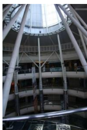
Gambar 3. Skylight pada Atrium Galaxy mall
