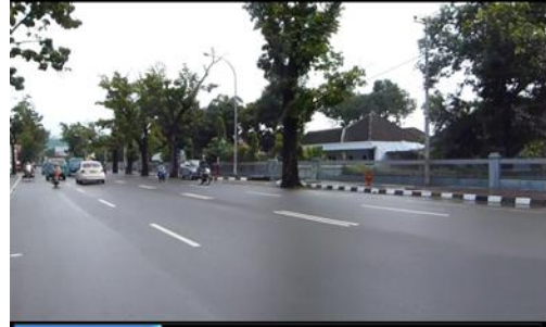
Gambar 5. Kondisi koridor perumahan
